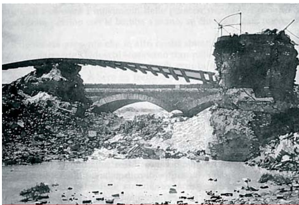
Ponte sul fiume Chienti distrutto dai tedeschi – dagli archivi del 2° Corpo polacco (per gentile concessione di M. Bialkiewicz, Londra)
